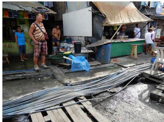
同 Stub-out 方式に接続されている給水管。敷設は主として露出配管である。その形状から、「スパゲティ配管」とも呼ばれ、フィリピンのバラングイ給水では良く見られる。
