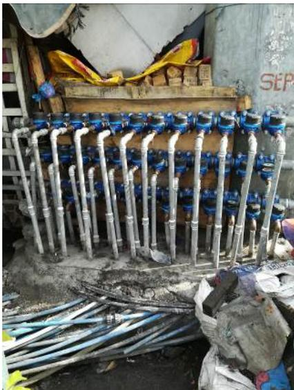
マニラ市内の集中水栓取り出し方式。本方式は、Stub-out 方式と呼ばれ、フィリピン国内で多く採用されている。（2017 年 12 月 1 日）
