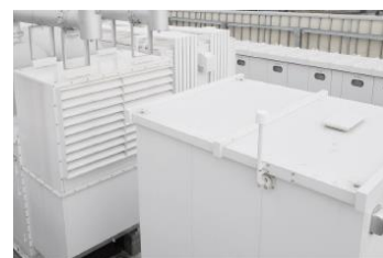
自家発電設備
