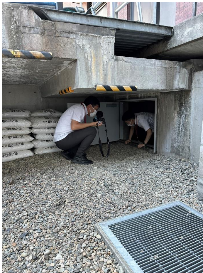
免震槽への狭い入口
