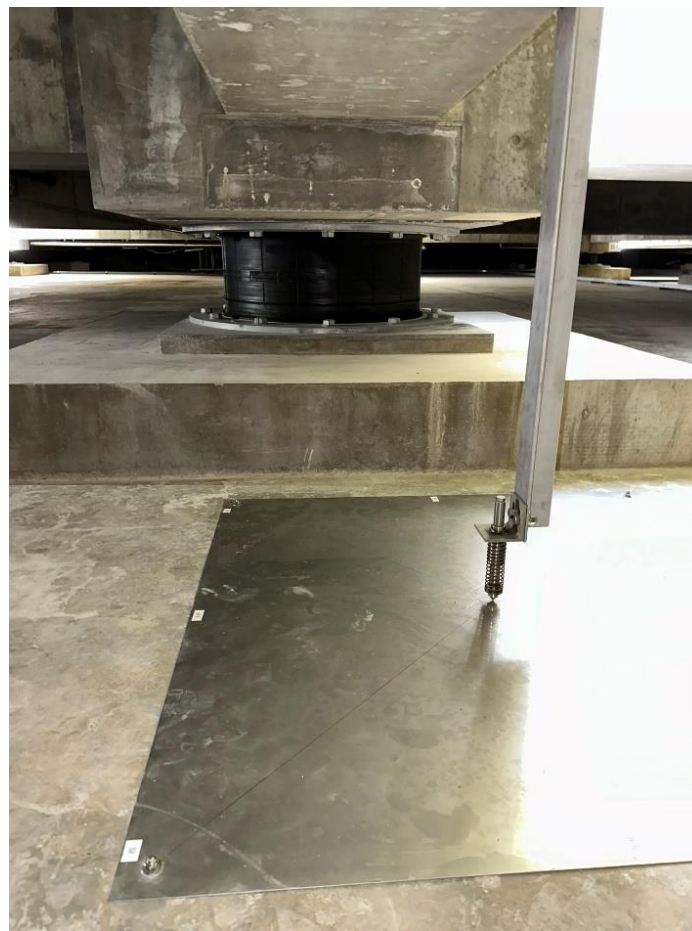
免震槽（上：免震ゴム（49基）下：野書板）
