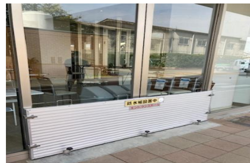
(止水板の設置)
