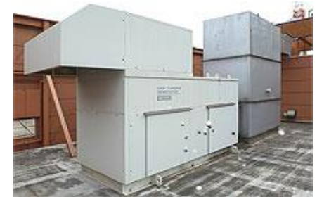
(非常用自家発電装置)
