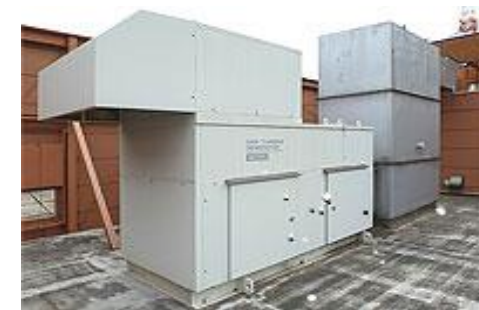
(非常用自家発電装置)
