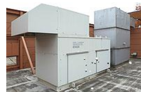
(非常用自家発電装置)
