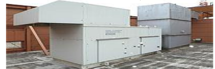
（非常用自家発電装置）
