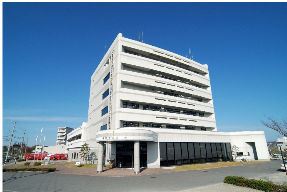
豊田市消防本部
