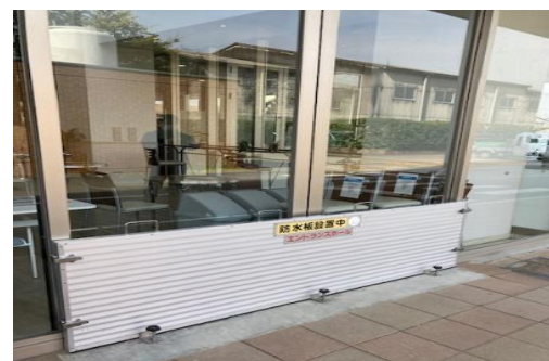
(止水板の設置)
