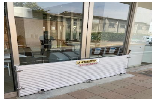
(止水板の設置)
