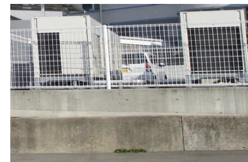
(電気設備の移設)
