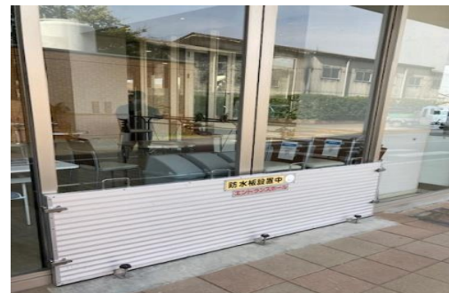
(止水板の設置)
