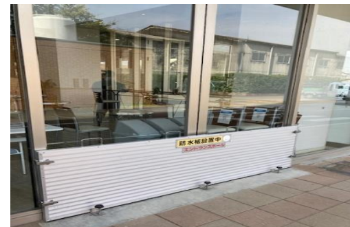
(止水板の設置)
