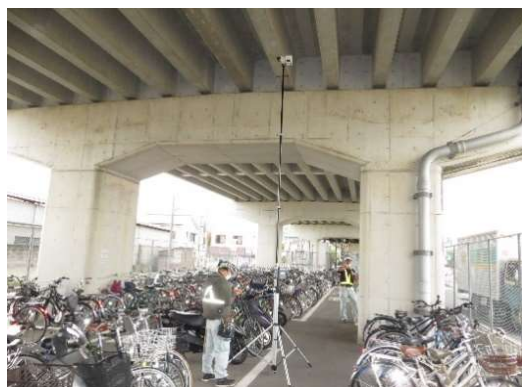
●ロボットカメラ点検
