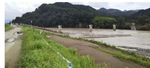
送水管を添架していた沖鶴橋の流出 (熊本県球磨村)
