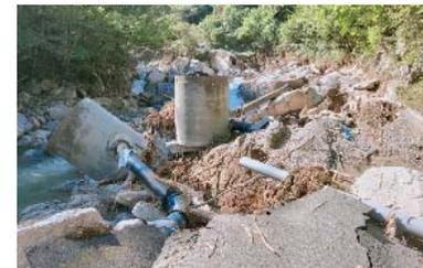
丸森町石羽浄水場の取水口流出
