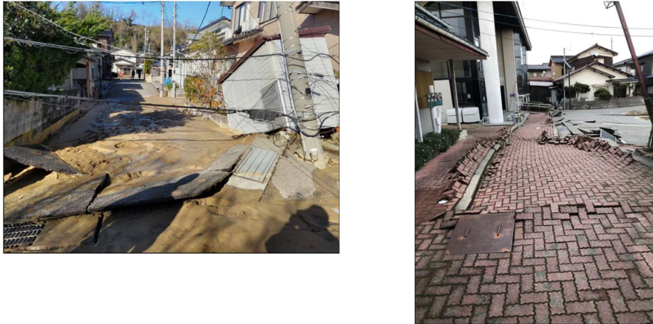
図 1-6 内灘町の液状化の様子
