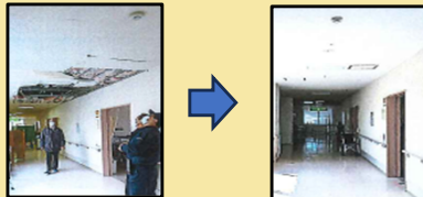
【介護施設の復旧の様子】
