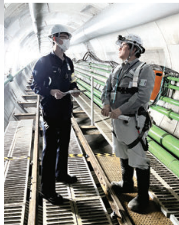
建設パトロール
