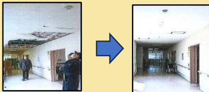
【介護施設の復旧の様子】
