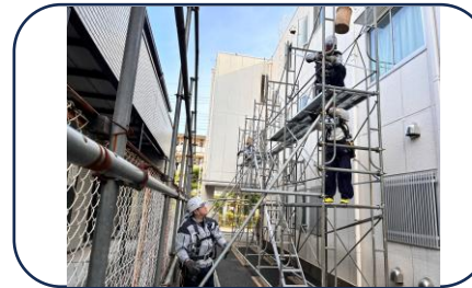
↑足場実習も段階的に難易度を上げていきます。
