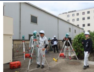
○土木新人・技能講習コース 測量研修
