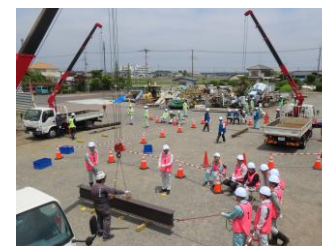
○土木新人・技能講習コース 玉掛け技能講習
