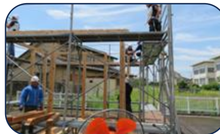
↑ 足場建方講習
