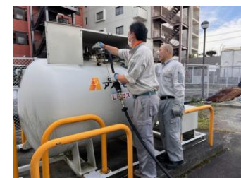
↑充てん作業実習風景。
