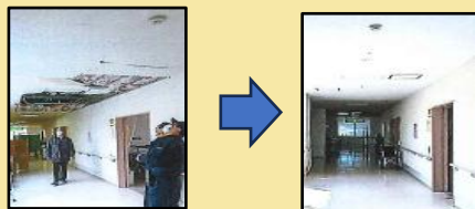
【介護施設の復旧の様子】
