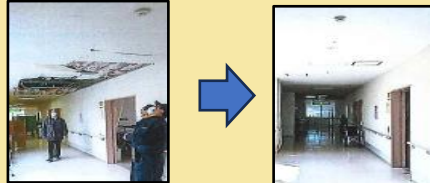
【介護施設の復旧の様子】
