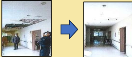
【介護施設の復旧の様子】
