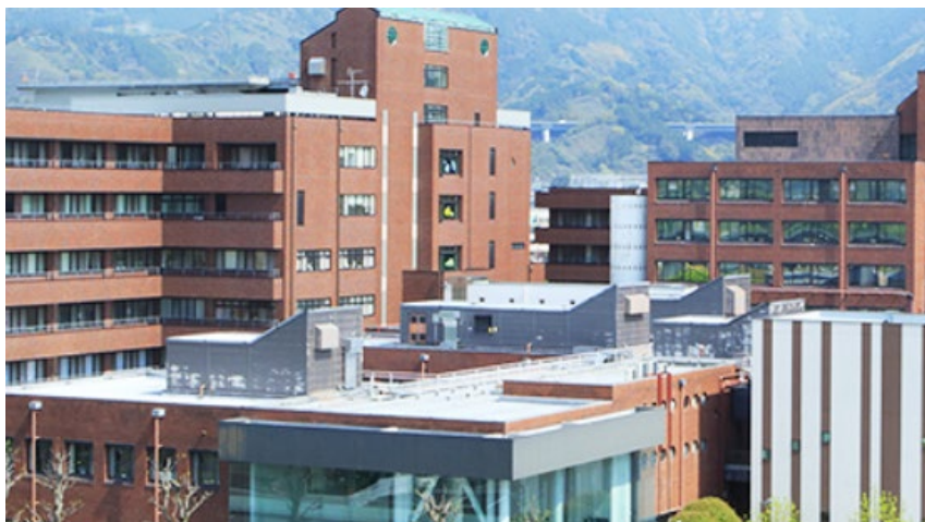
静岡県移行期医療支援センター外観
