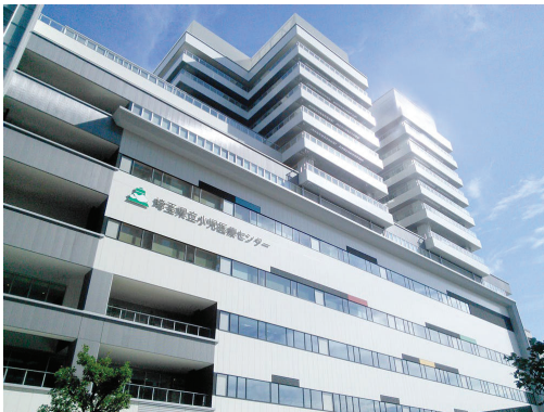
埼玉県移行期医療支援センター外観
