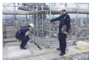
建設現場の確認
