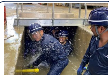
↑ 埋設物損傷事故を疑似体験することで基本作業の大切さを学びます。
