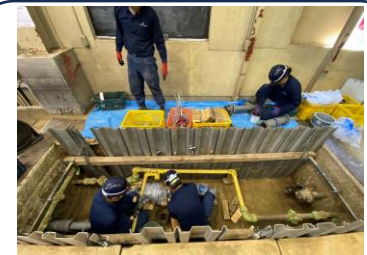
↑ 配管作業を実践に近い形で訓練を行います。
