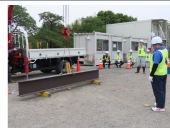
○土木新人・技能講習コース 玉掛け技能講習
