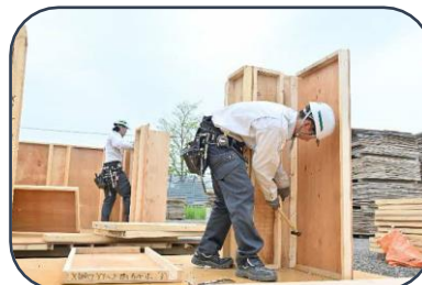
↑ 型枠模型組立 個人訓練
