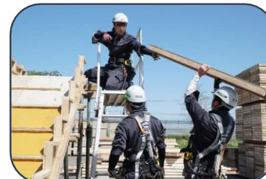
↑ 型枠模型組立 共同訓練
