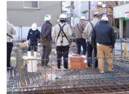
第4回目 スラブ配筋検査 ※検査者は設計事務所の 品質管理担当
