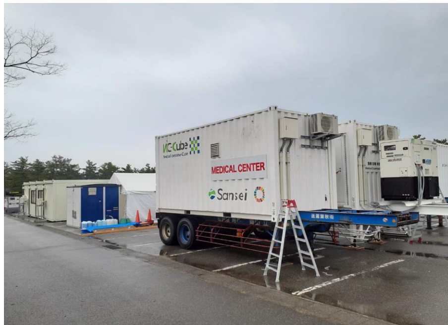
写真 SCU に設置された医療コンテナ
