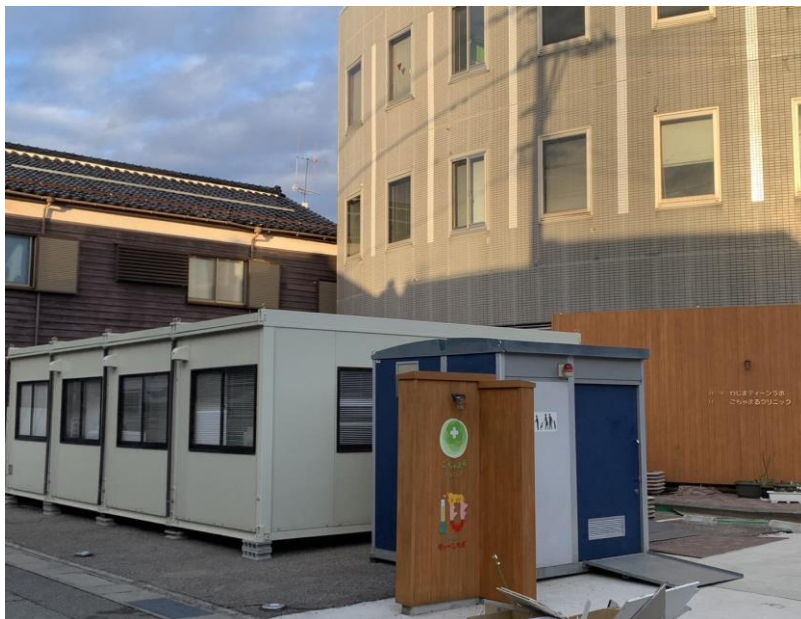
写真 ごちゃまるクリニックに設置された医療コンテナと仮設トイレ
