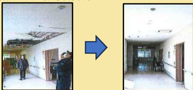
【介護施設の復旧の様子】
