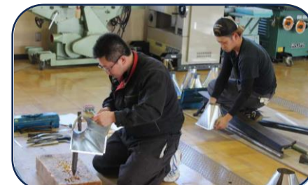
↑ 建築板金科：板金の曲げ加工（かりだし）の作業中です
