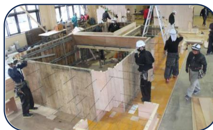
↑ 型枠施工科：型枠製作実習
