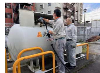
↑充てん作業実習風景。
