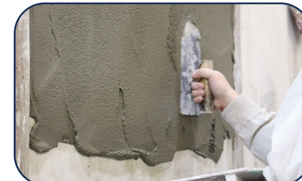
↑左官・タイル施工科 基本の塗り作業
