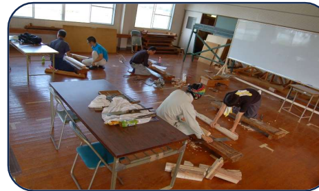
木造建築科での実習風景
