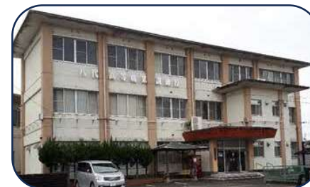
↑ 外観。実習棟は訓練校裏にあります。
