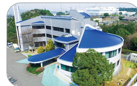
↑外観 駐車場完備 バリアフリー
