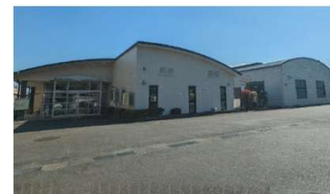
↑ 講習会会場は滋賀県職業能力開発協会実習棟 駐車場完備
