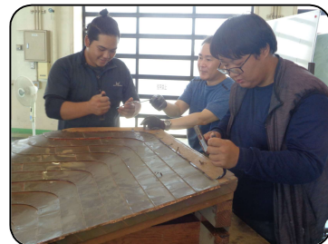
↑訓練生によるイベント場での銅板屋根葺きの実演に向けての訓練風景です。
