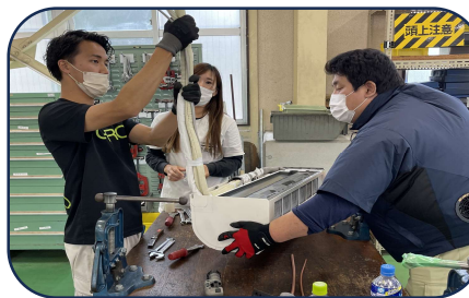
↑ エアコンの配管実習
