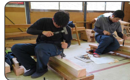
木造建築科 (木材のホゾ穴加工風景)
