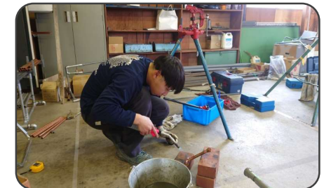
配管科 (銅管の溶接作業風景)
