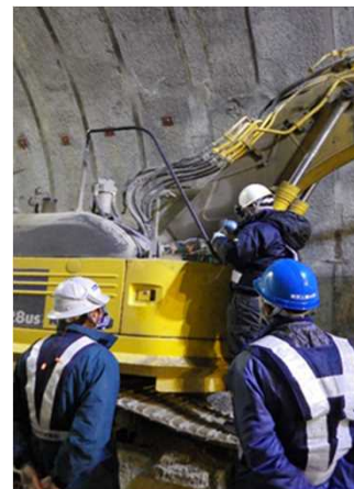
(3) 車両系機械を用いた測定
