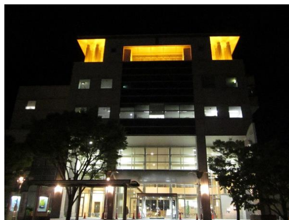
大阪府河内長野市 （市民交流センターライトアップ）
