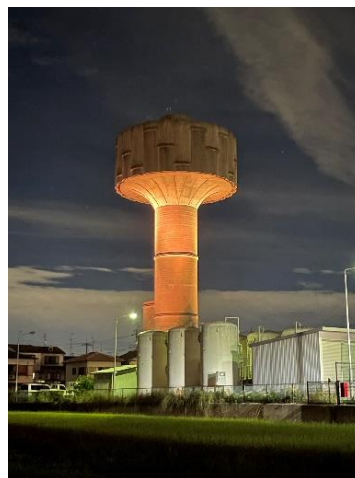
京都府向日市 (向日市上植野浄水場配水塔)
