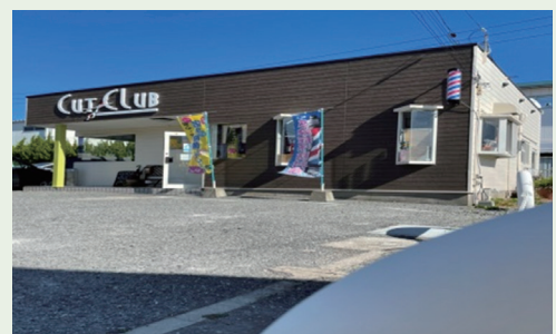
サインポールを撤去し建物上部に新規設置。駐車場を広く、かつ視認性を上げた
