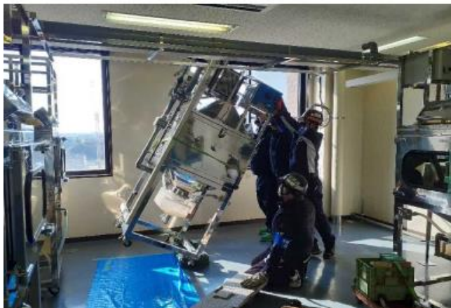
図 3 吸入曝露チャンバー撤去作業
