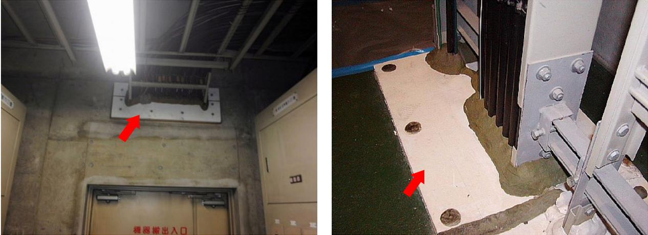
図 2.25 壁や床のケーブル貫通部の処理（けい酸カルシウム板第2種）
