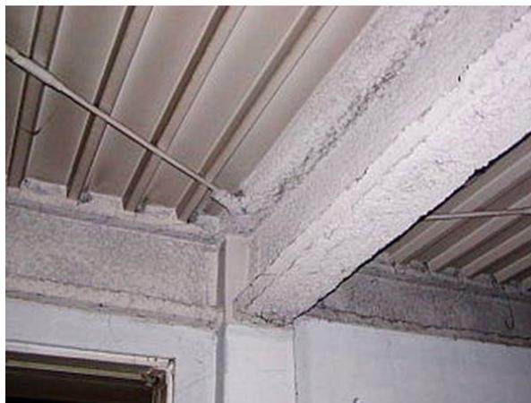
図 2.8 耐火被覆板と吹付けを併用する耐火構造
