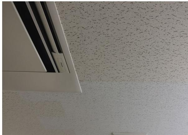
写真左：化粧せっこうボード（通称として使用される商品名：ジプトーン）の施工例。軽天にビス止めしており、継ぎ目が見える。
