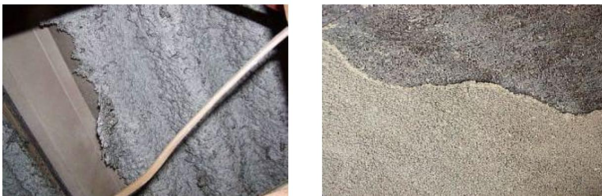
写真左：折板屋根の吹付け石綿の層状界面はく離
