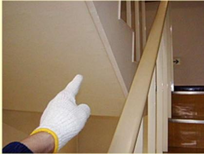
階段の段裏の仕上げ材、吸音材として使用されている
