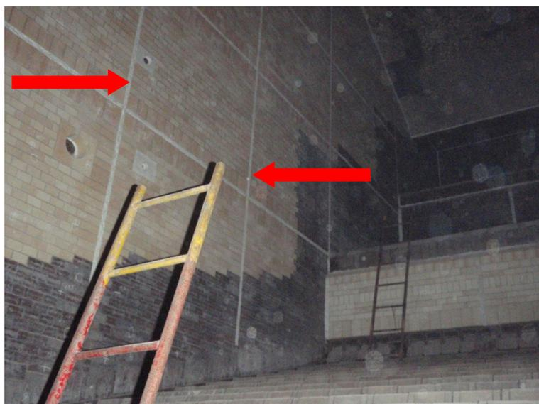
図 2.79 燃焼室の炉内側の耐火レンガと熱膨張しるエキスパンション（赤矢印の部分）
