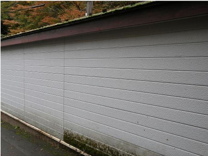
壁（裏打ち材に石綿含有のボード類を使用）
