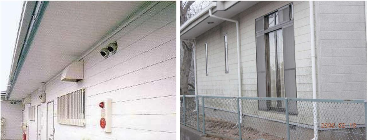
10 図 2.59 石綿含有窯業系サイディングの施工例
