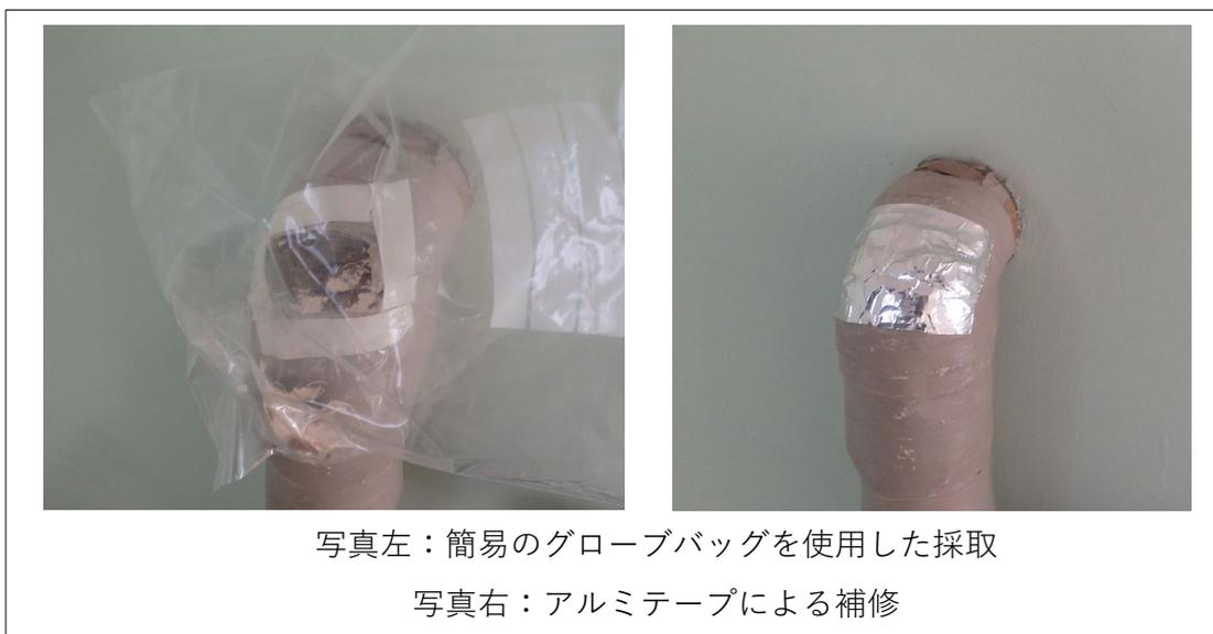
図3.21 配管保温材の採取
