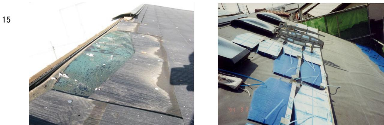
20 図 2.64 石綿含有ルーフィングの施工例
