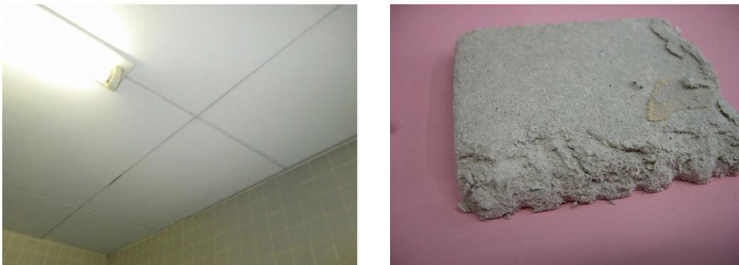
15 図 2.49 石綿含有パーライト板の施工例（左）と建材の近撮（右）
