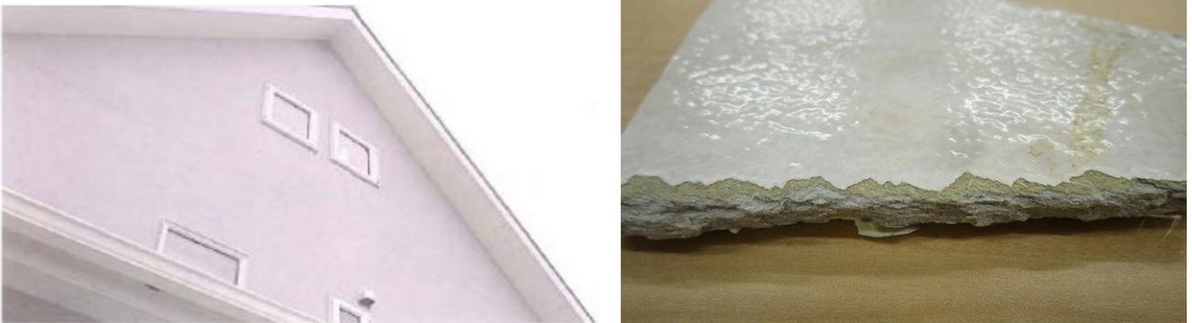
20 図 2.41 石綿含有スラグせっこう板の施工例（左）と建材の近撮（右）
