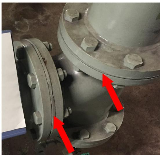
図 2.38 配管に使用されているガスケット（赤矢印の接合部のすき間部分）
